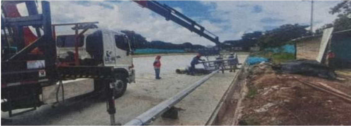
Izada de elementos prefabricados para módulos de pista
