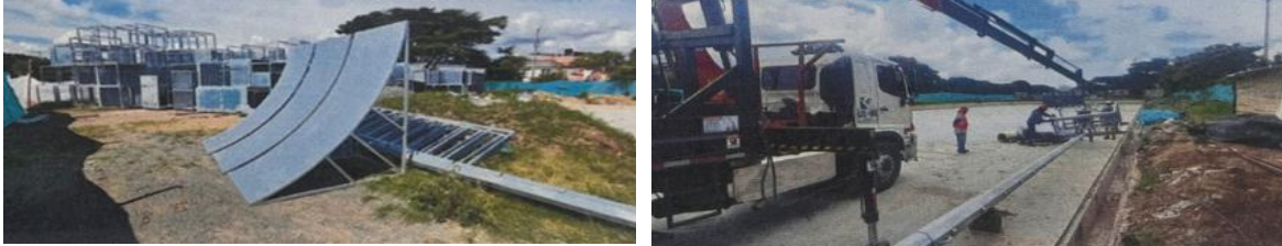
Foto No. 4 Rampas de la pista de BMX e Izada de elementos prefabricados para módulos de pista
