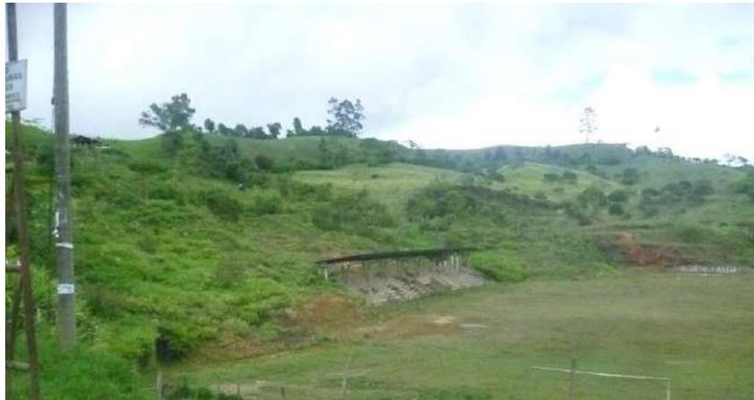
**GRADERIA CON DESLIZAMIENTO A LADO Y LADO**
