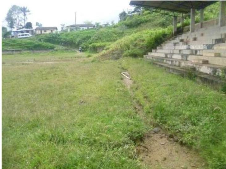
**CANAL QUE RECOGE LAS AGUAS DE CUBIERTA E INGRESA A LA CANCHA CON DESCOLE A TERRENOS ALEDAÑO A LA CANCHA**
